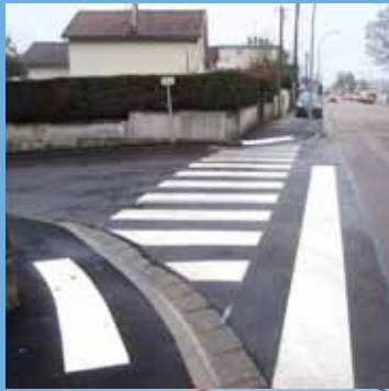
Travaux de voirie
