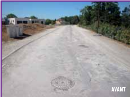
Rue des vannes
