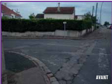
Création d'un passage pour piétons rue des Couturots
