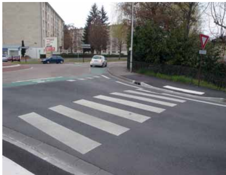
Création d'un passage piétons au rond-point André Malraux
