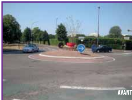
Rénovation du rond-point allée du château des cours
