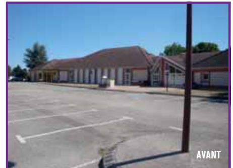
Réalisation des accès PMR à la salle polyvalente
