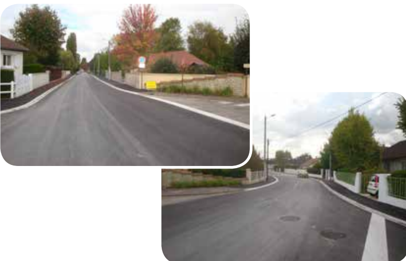
Photos après travaux (octobre 2017)
