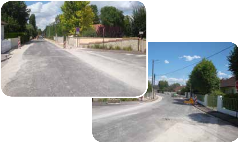
Photos avant travaux (juillet 2017)
