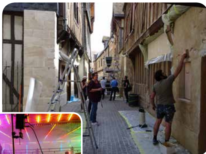
Installation de décors rue Larrivey (Troyes)
