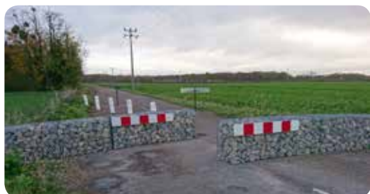
Après travaux : les gabions
