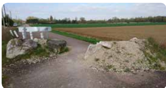
Avant travaux : les tas de gravats
