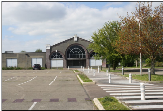
Façade Sud - « Bâtiment 3 »
