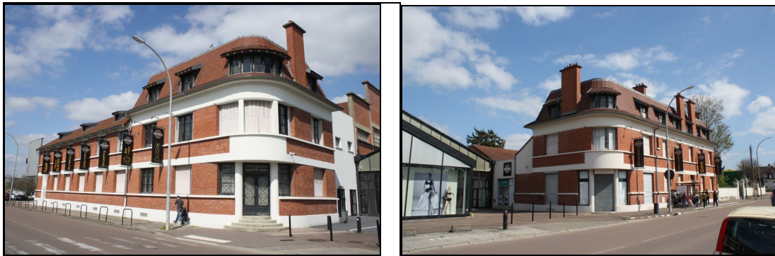
Façades Ouest - « Bâtiment 1 »
