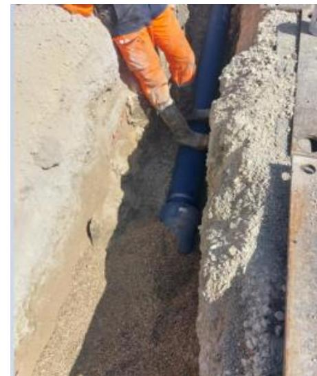
3/ Enrobage de la conduite en 4/8 roulé jusqu'à 20 cm au-dessus de la génératrice supérieure
